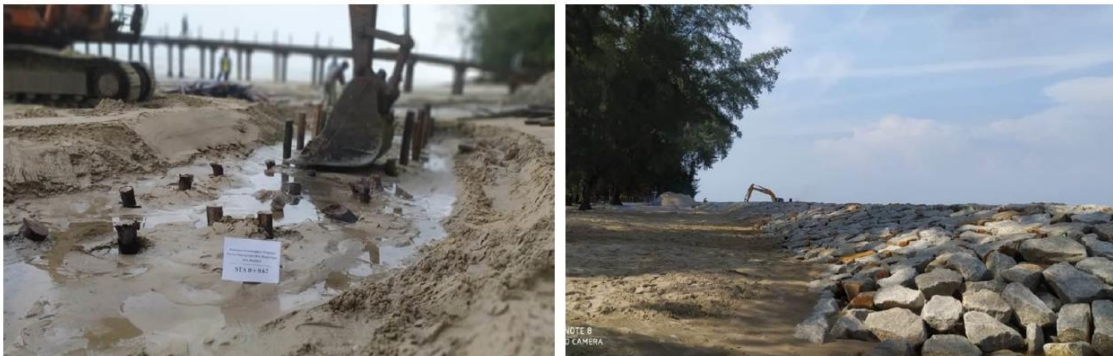
Pembangunan tanggul sungai
